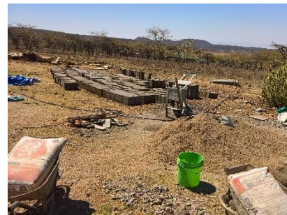
Herstellung der Betonsteine (Oktober - Trockenzeit)
